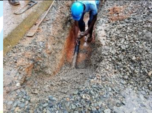
Instalación de tubería y relleno
