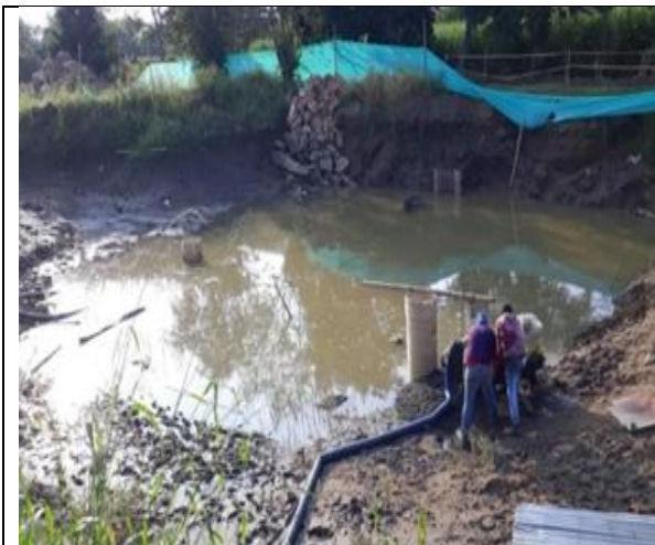
Cerramiento Utilizando Tela Verde Y Limpieza De Los Pozo De Sucion.
