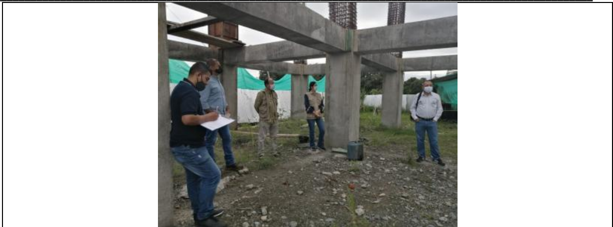
Reunión tanque alto de almacenamiento de Emtulua S.A E.S.P
