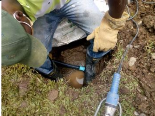
Instalación de acometidas Córdoba
