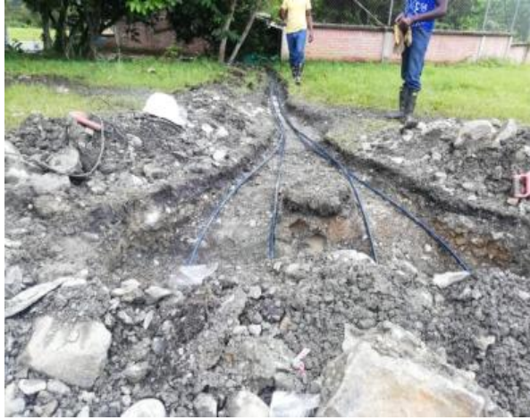
DESCRIPCION: Se observa la instalación de acometidas
