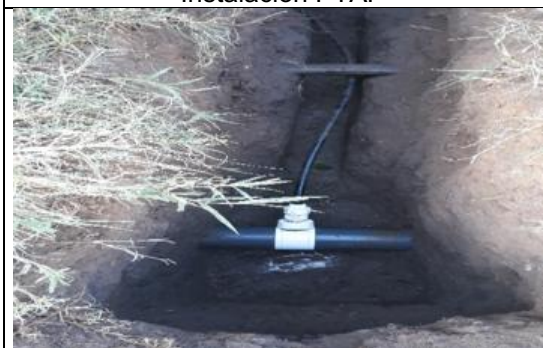
Instalación de acometidas
