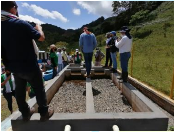
Recorrido por infraestructuras con alcaldia municipal – Filtro Grueso
