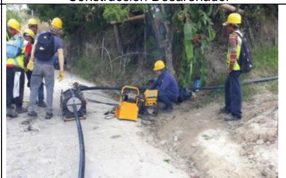
Instalación de tubería
