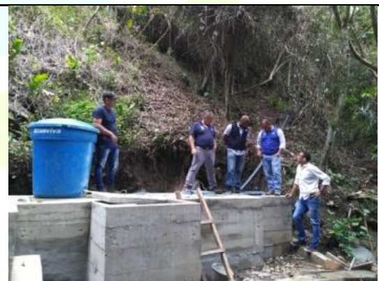
Construcción Desarenador
