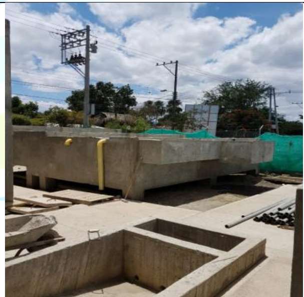
Esstructuras De La Planta De Tratamiento, E Inicio De Las Instalaciones Hidraulicas.
